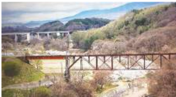
旧立場川鉄橋と中央道
