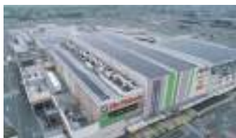
CO 2 排出量削減のために 店舗に設置した「太陽光発電パネル」
